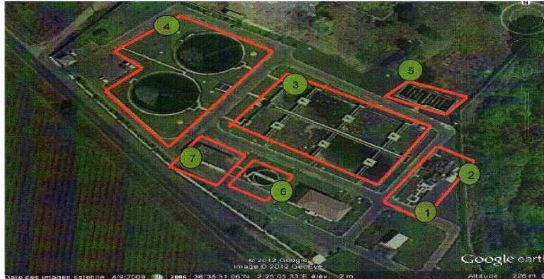
Figure III.1 : Photo de la STEP par Google earth
