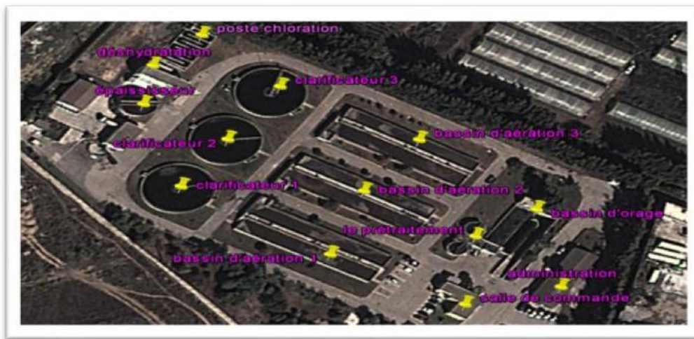
Figure I.1: Vue d'ensemble des ouvrages de la STEP de Boumerdes.
