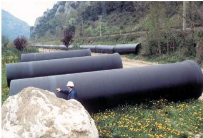
Figure II. 6 : conduite de type fonte ductile zinc + peinture bitumineuse
