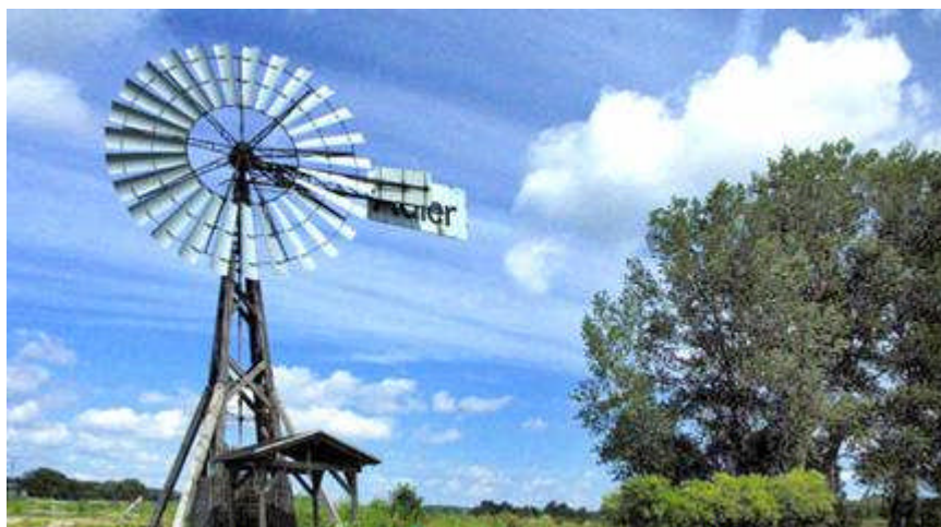
Fig.1.3 Moulin à vent (Allemagne du Nord)
