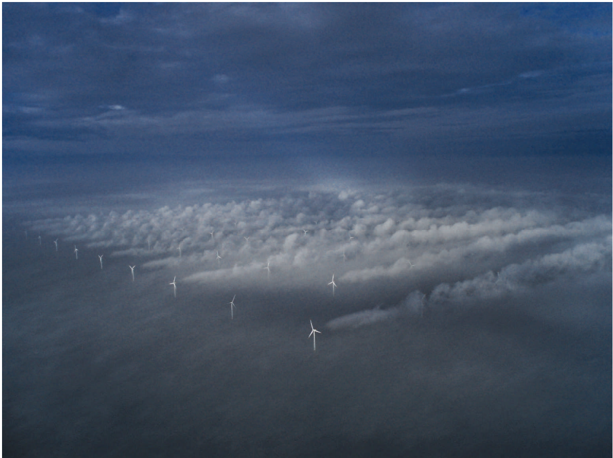
Fig.2.3. Photo d'une ferme éolienne de HORNS REV [23]
