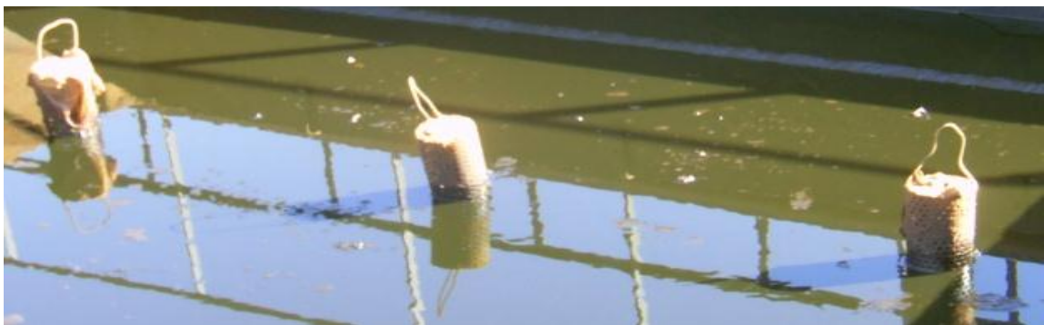
Photo II.1 : chapeaux chinois bouchés, et la couche d'huile n'est pas récupérée
