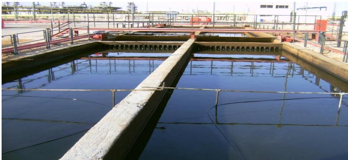
**Photo II. 3:** les deux compartiments du bassin API en fonctionnement
