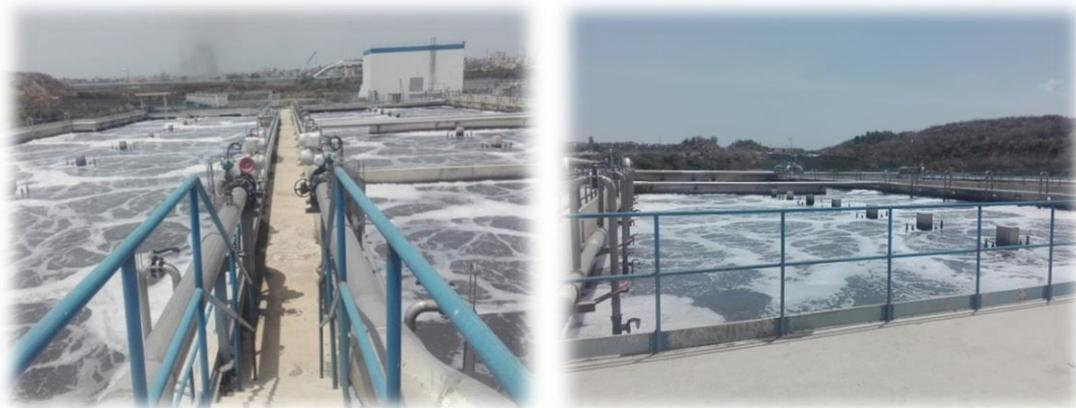
**Figure 11** : Bassins d'aération de la station d'épuration de Baraki.
