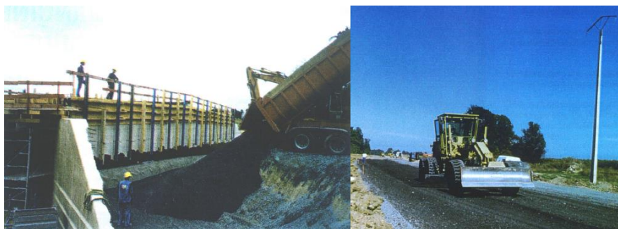
Figure 3.8 : Utilisation des MIOM en technique routière
