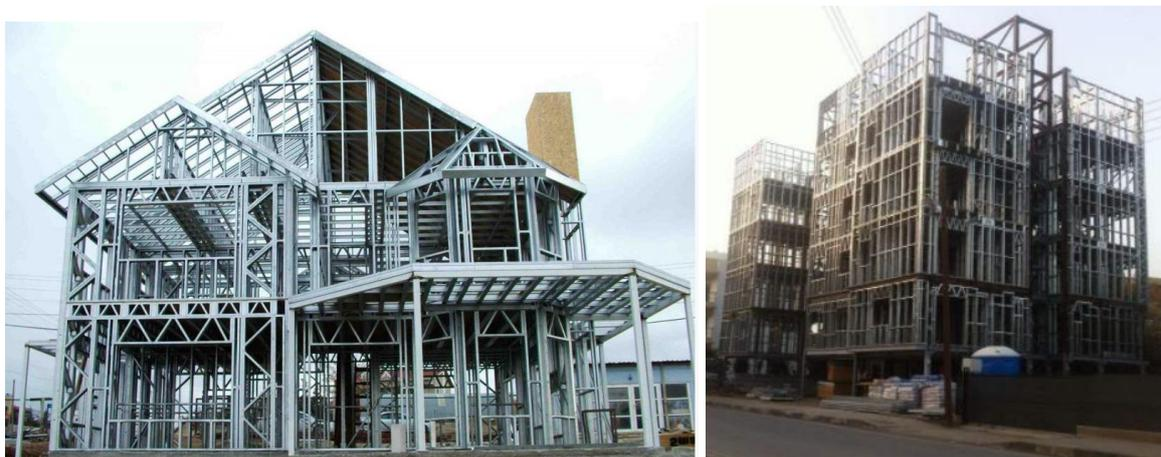
*Figure 5.2 : Structures avec des éléments en type PAF*
