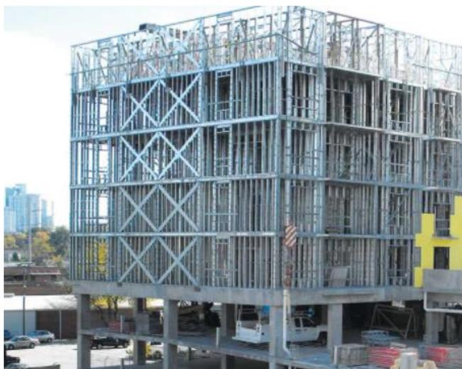
Figure 5.7 : Ossature typique avec panneaux en éléments individuels et stabilités
