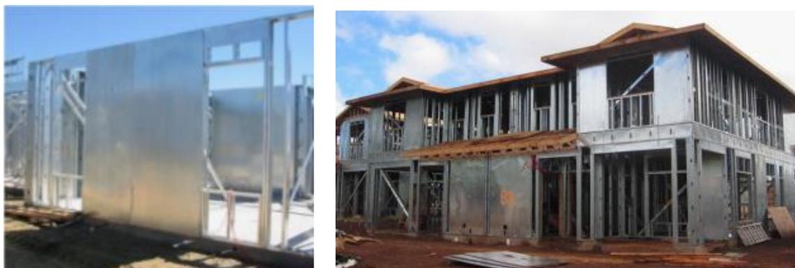
Figure 5.5 : Ossature avec des panneaux en acier léger
