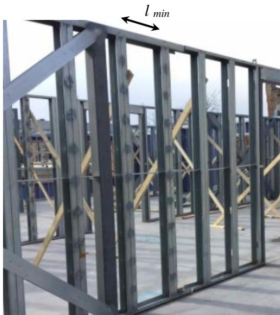
Figure 5.14 : Distance minimale entre deux montants
