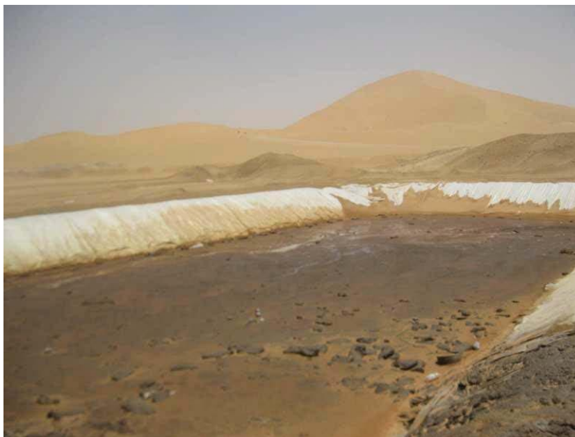
FIG. 4.7 : Sécuriser la décharge avec un revêtement synthétique (MESP Spa)
