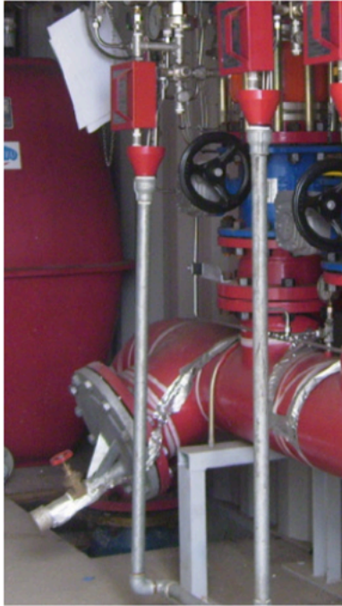
Figure 2-15 : Filtre en Té, amont vanne déluge à membrane (gauche). Piège à cailloux, aval vanne déluge papillon (droite) [3]
