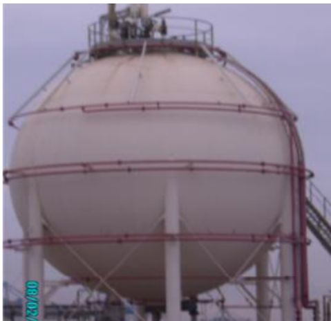
Figure 2-11 : Déluge par quadrillage (gauche), Déluge zénithal (droite) [2]
