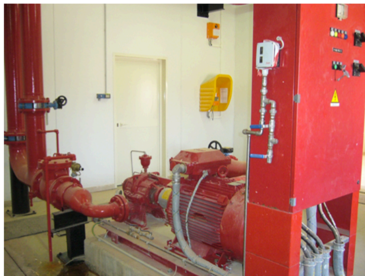
Figure 2-6 : Pompe électrique incendie [3]
